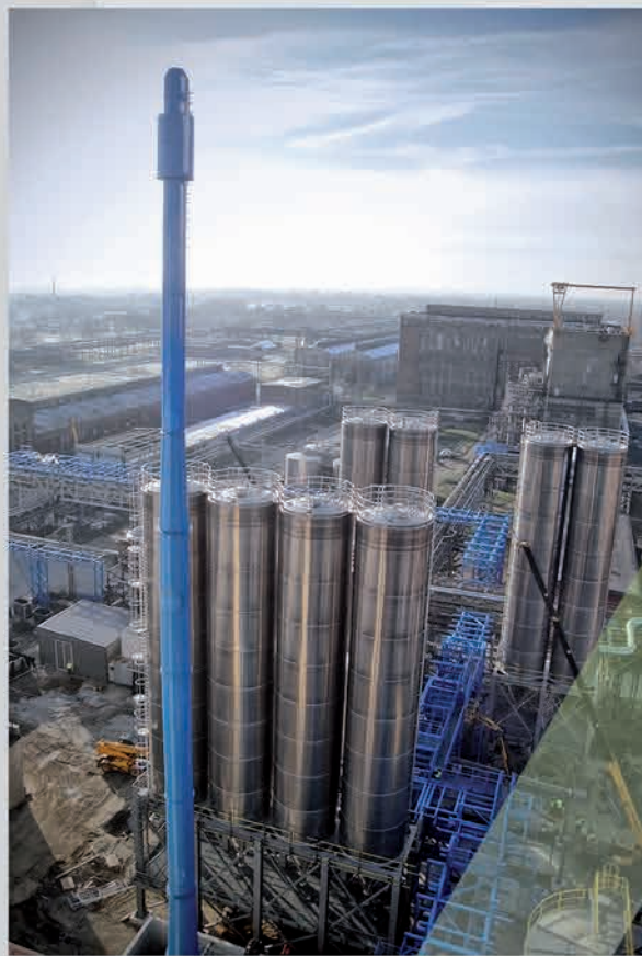
Wykonanie i montaż rurociągów (247 ton) oraz montaż aparatów (263 sztuki) dla Wytwórni Poliamid II dla Grupy Azoty S.A. w Tarnowie
