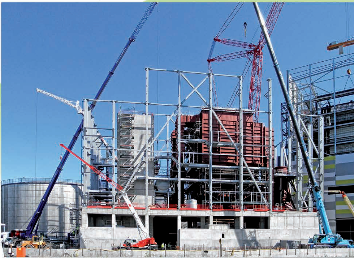
Dostawa, montaż i izolacja instalacji oczyszczania spalin w Västerås w Szwecji
