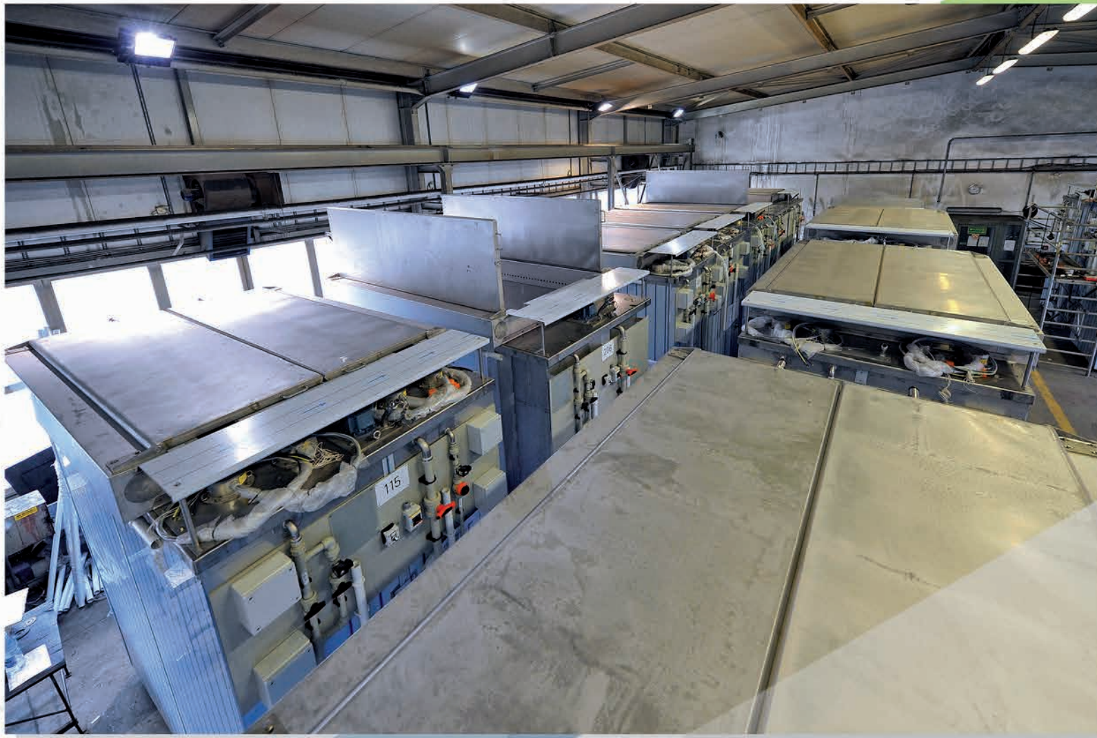
Wykonanie zbiorników galwanicznych dla General Electric w Zjednoczonych Emiratach Arabskich
