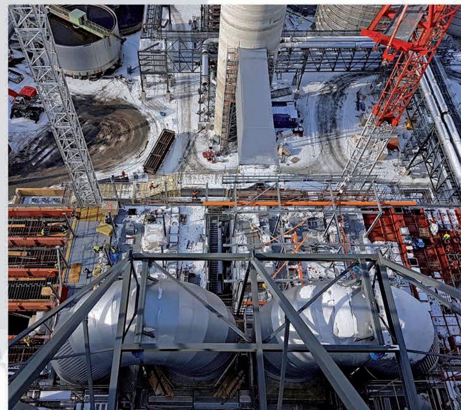
Montaż pięciu elektrofiltrów dla instalacji bioproduktu budowanej przez Metsä Fibre Oy w Äänekoski w Finlandii
