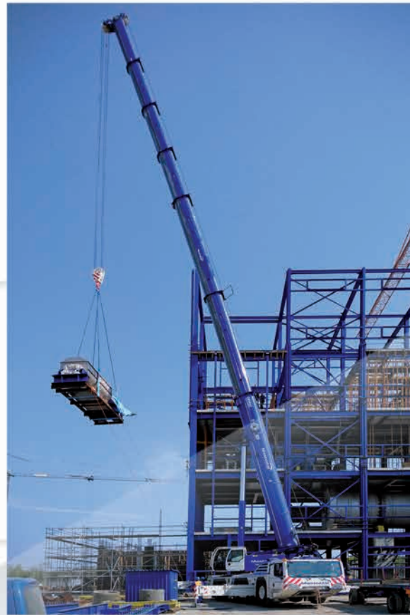
Realizacja projektu pn.: Wytwórnia nawozów granulowanych na bazie salety amonowej w Zakładach Azotowych „Puławy” S.A.
