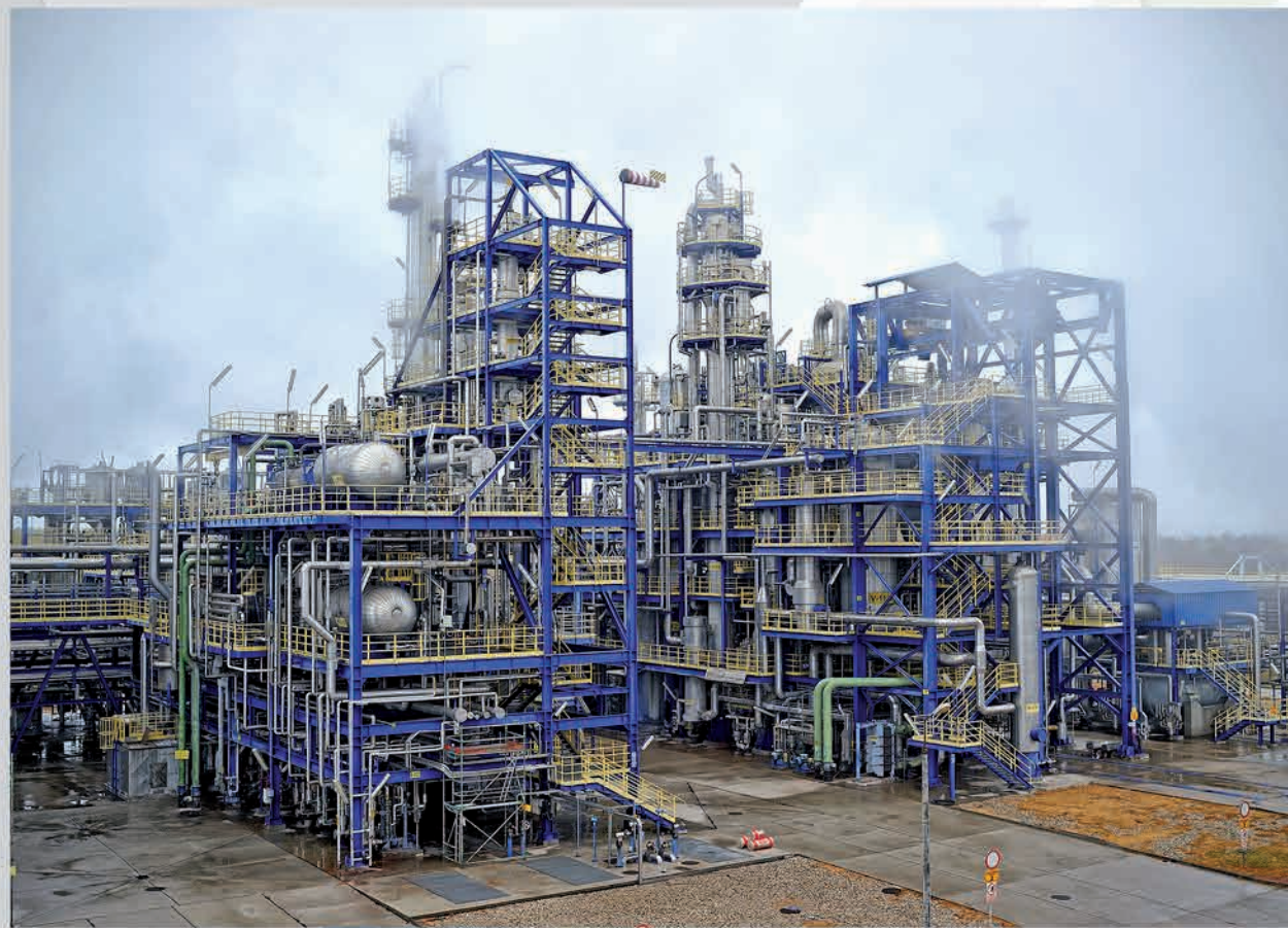
Realizacja w systemie Generalnego Wykonawcy zadania inwestycyjnego pn.: Budowa Wytwórni Melaminy III w Zakładach Azotowych „Puławy” S.A.
