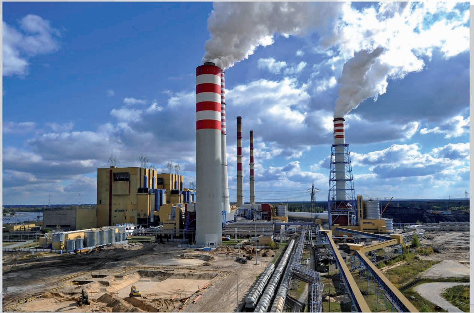
Przebudowa estakady transportu hydraulicznego popiołu i żużla oraz rurociągów wody powrotnej ze składowiska w Elektrowni Kozienice
