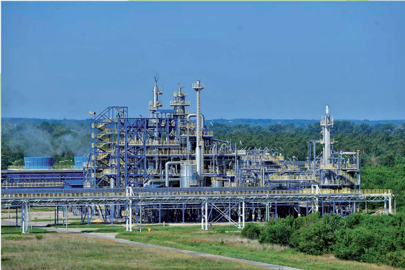
Realizacja w systemie Generalnego Wykonawcy zadania inwestycyjnego pn.: Budowa Wytwórni Melaminy II w Zakładach Azotowych „Puławy” S.A.
