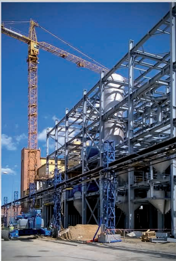
Wykonanie i montaż rurociągów (247 ton) oraz montaż aparatów (263 sztuki) dla Wytwórni Poliamid II dla Grupy Azoty S.A. w Tarnowie
