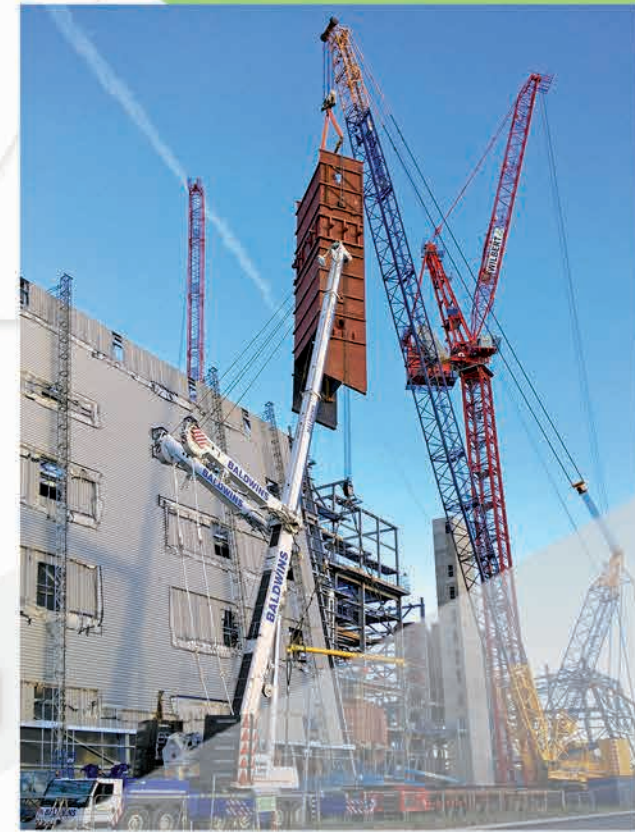
Montaż części ciśnieniowych dwóch kotłów o mocy 62,6 MW th w spalarni odpadów Severnside o przepustowości rocznej 388 000 t/rok w Bristolu w Wielkiej Brytanii
