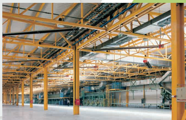
Zakłady Azotowe „Puławy” S.A.
