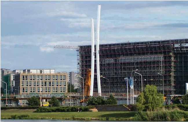
Pylon kładki nad jeziorem Malta w Poznaniu
