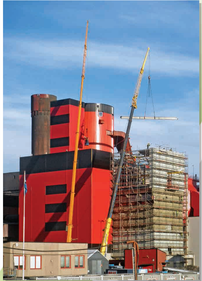
Kopalnia LKAB Svappavaara w Szwecji
