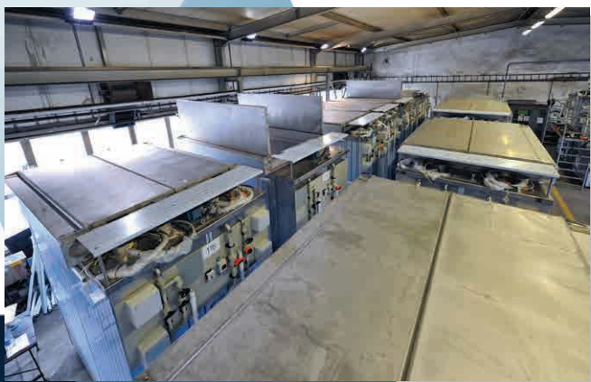
Wykonanie zbiorników galwanicznych dla General Electric w Zjednoczonych Emiratach Arabskich
