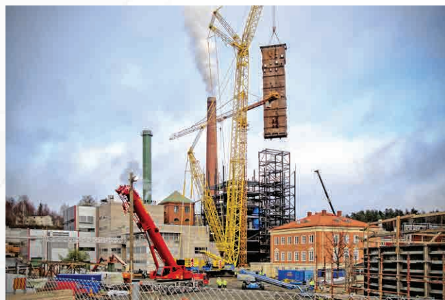
Montaż kotła na biomase dla elektrociepłowni Havo w Finlandii
