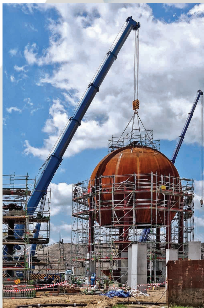
Magazynowe zbiorniki kuliste dla PKN Orlen w Płocku
