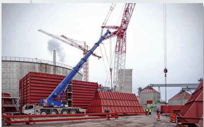
Dostawa, montaż i izolacja instalacji oczyszczania spalin w Västerås w Szwecji
