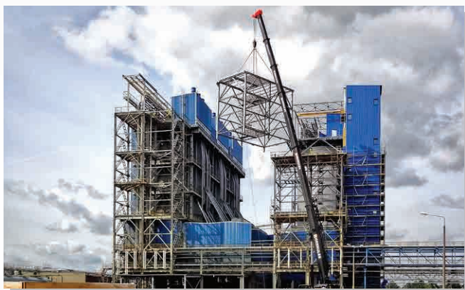
Montaż konstrukcji estakad do transportu popiołu i żużla w Elektrowni Opole
