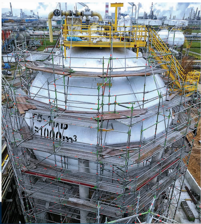
Magazynowe zbiorniki kuliste dla PKN Orlen w Płocku
