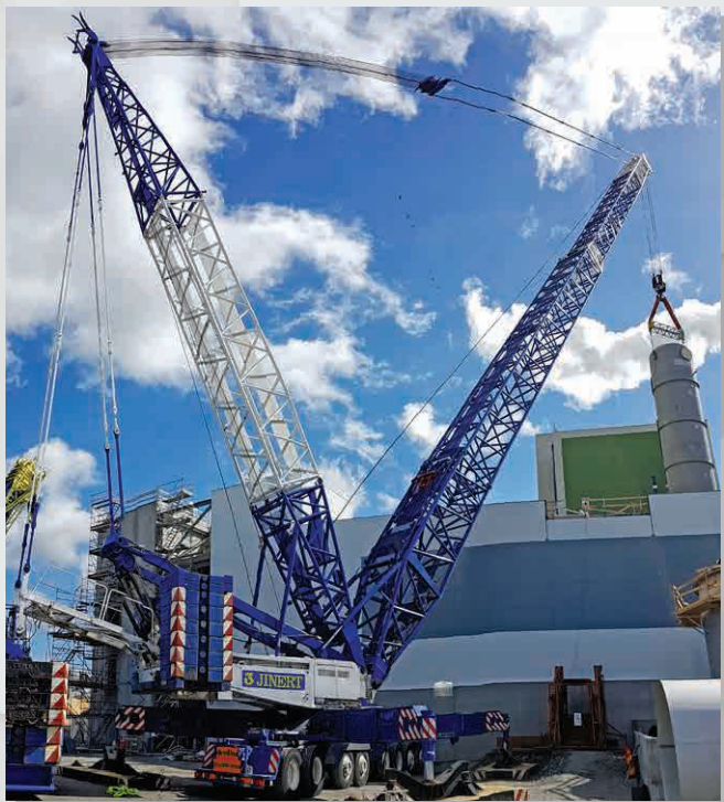
Montaż instalacji wyparek w papierni Södra Cell Mörrum w Szwecji
