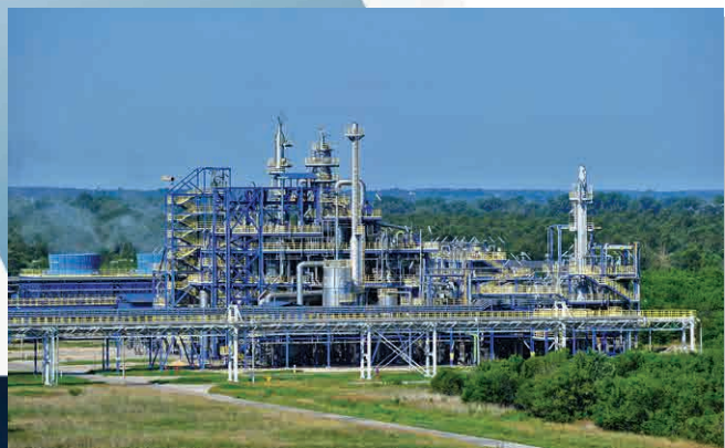
Melamina II w Zakładach Azotowych „Puławy” S.A.
